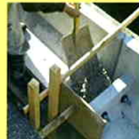
コンクリート打設状況
