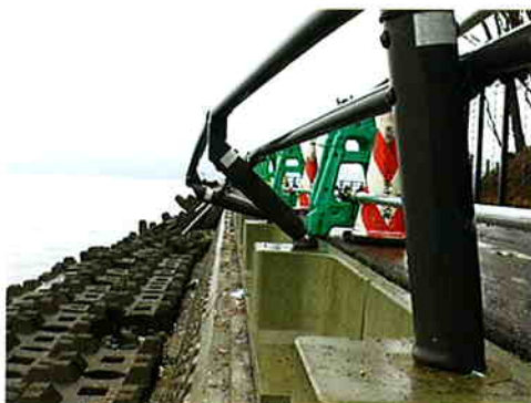
横方向から見た状況
