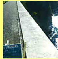
均しコンクリート
