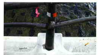
横断方から見た状況
