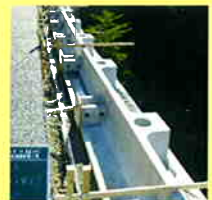
製品・型枠設置完了
