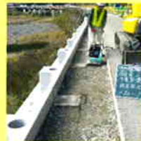
埋戻し、路盤施工
