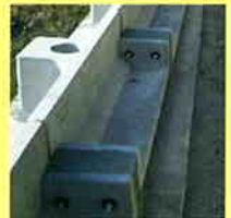
間詰めコンクリート完了
