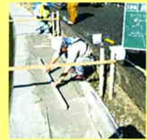
敷きモルタル
