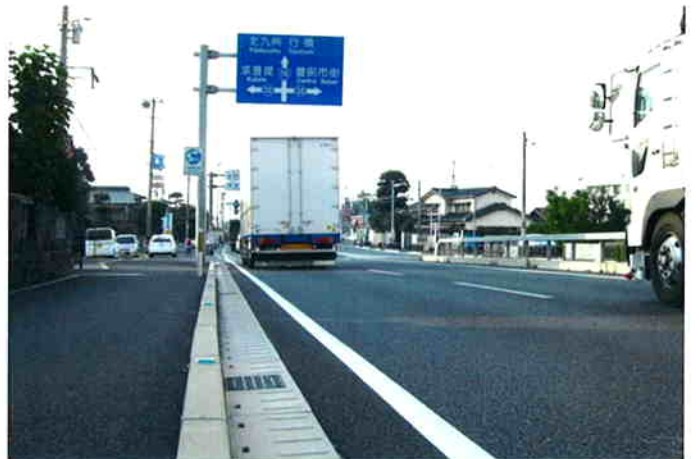
雑草の成長が殆んど確認できない暗渠形側溝と組み合わせて施工された歩車道境界ブロック
